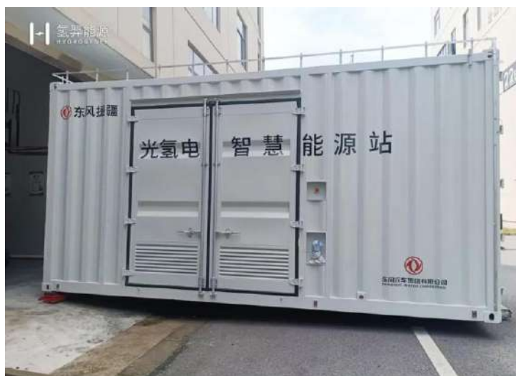
氢能能源による東風汽車研究院向け PEM 水電解水素製造統合システム
