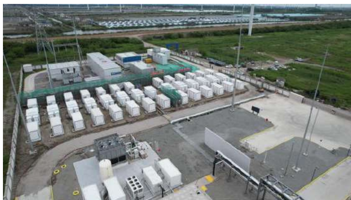
如東県洋口港における「洋上太陽光・水素・蓄電一体化」プロジェクトの現場
